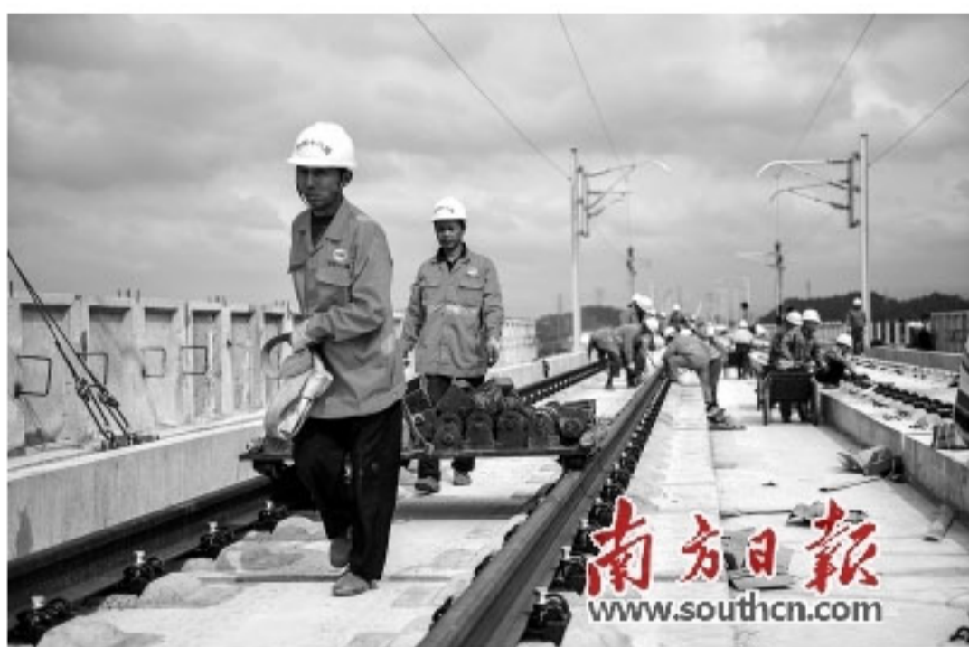
常平东到谢岗路段钢轨铺设正紧锣密鼓进行。王昌辉 摄
